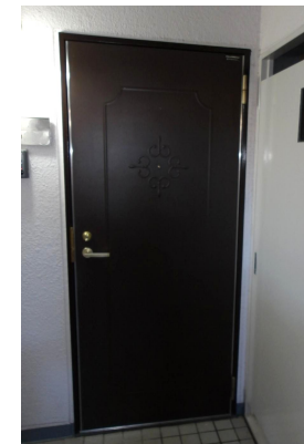
玄関ドア 改修前
