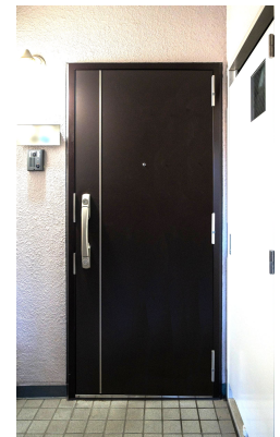
玄関ドア 改修後
