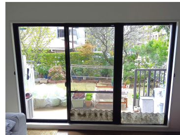
サッシ 改修前
