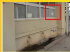
障子の落下箇所 (修繕後)
