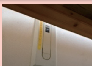
操作ボックス前に棚が 設置され操作不能
